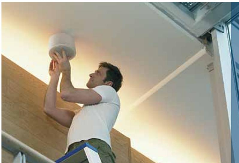
Em situações em que um altifalante não possa ser montado embutido, por exemplo, em tectos de superfície dura, uma moderna caixa de montagem saliente torna a instalação simples e elegante.
